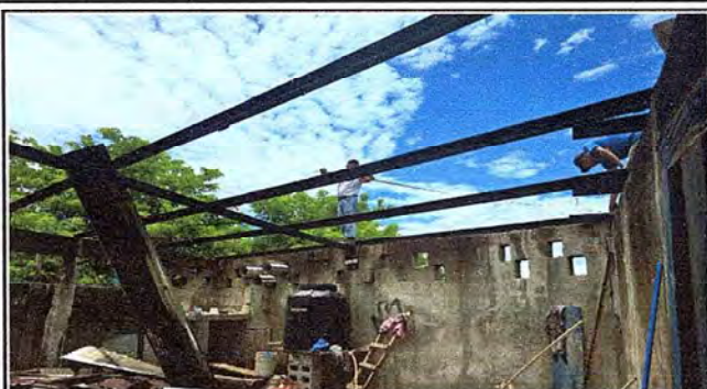
Foto 1: Desinstalación de cubierta de lámina en área de cocina.
