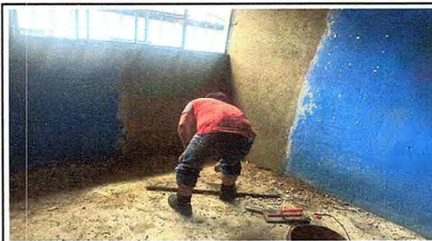
Foto 4: Reparación de repello y cernido en paredes de aulas.
