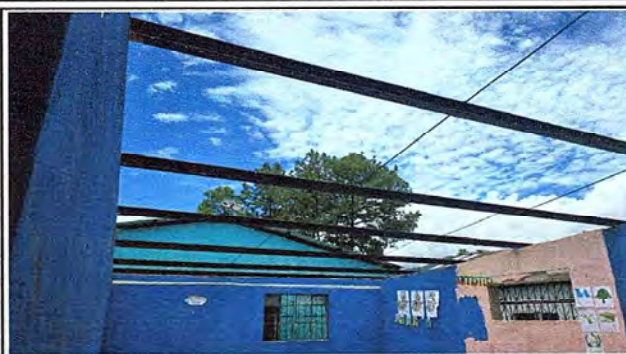
Foto 2: Cubierta de lámina desinstalada e inicio de trabajos de mantenimiento a estructura de techo en aulas 1 y 2.
