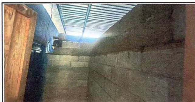
Foto 5: Reparación de paredes de block.
